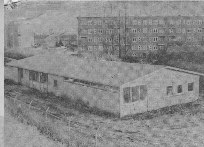
Het nieuwe Scoutingcentrum voor Presikhaaf aan de IJssellaan bij het Voetiusviaduct.
